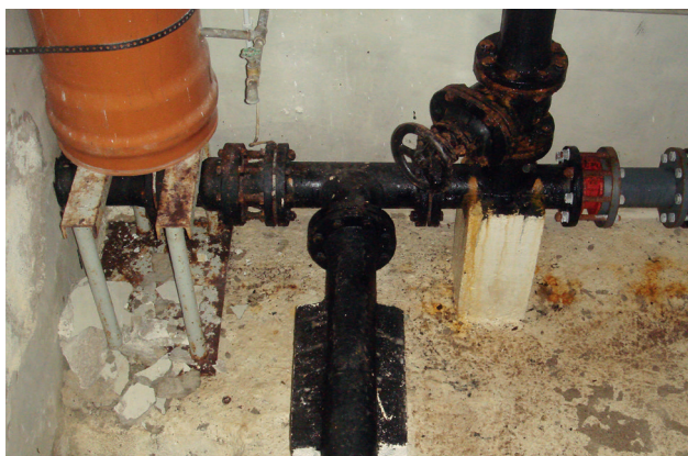
Fig.3: Fuktskader
