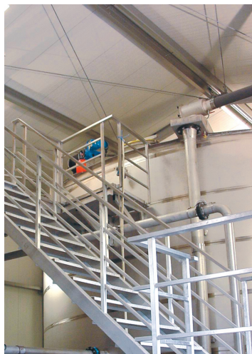
Plattform- og trappekonstruksjoner
