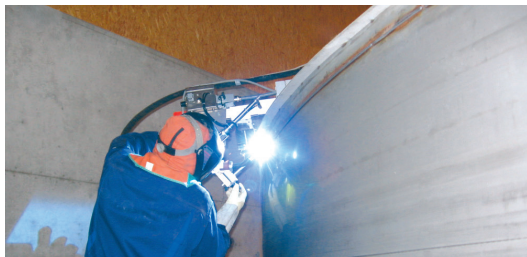
Kjegletaket sveises fast til beholderkappen.
