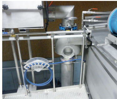
Overløp med vannlås
